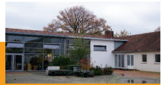
Die ehemalige Grundschule wurde um einen Anbau erweitert, um das Gebäude zum Bürgerhaus umnutzen zu können.
